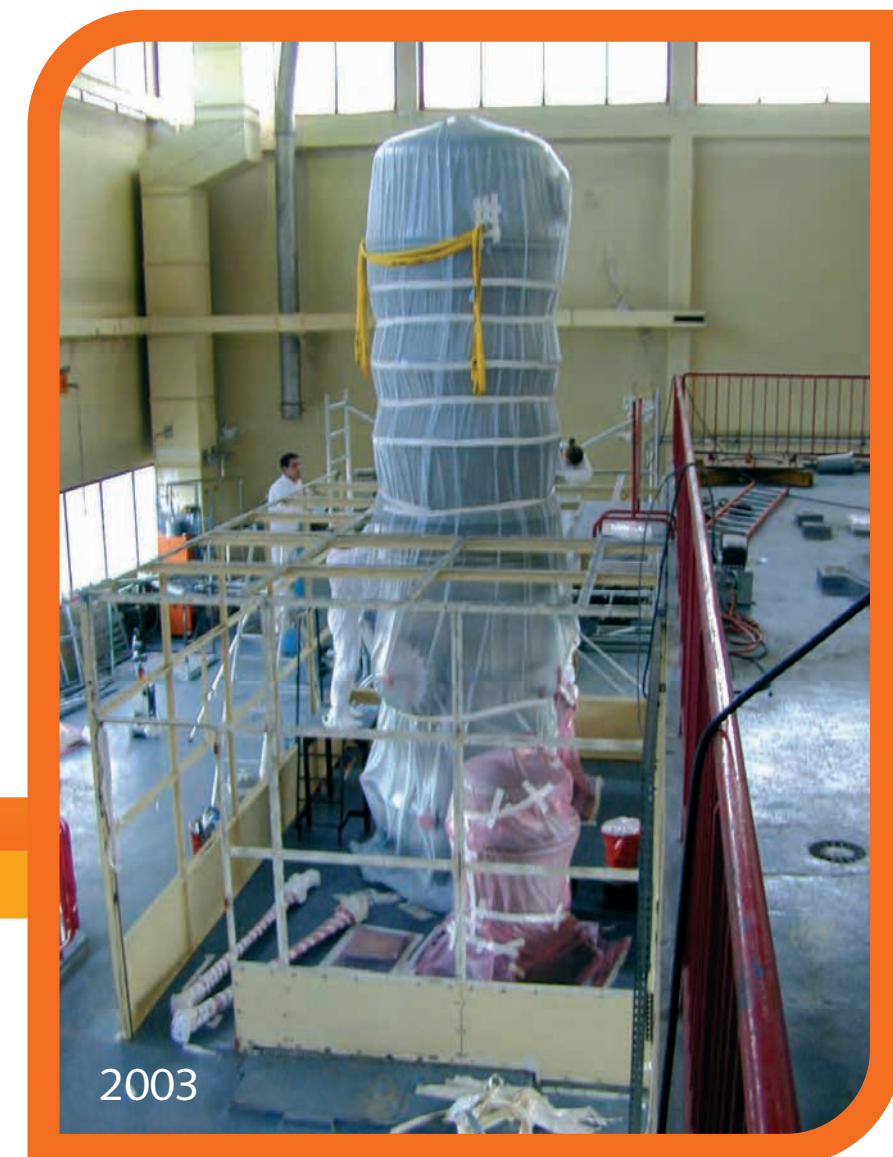
Le procédé en cours de démantèlement (2003).
