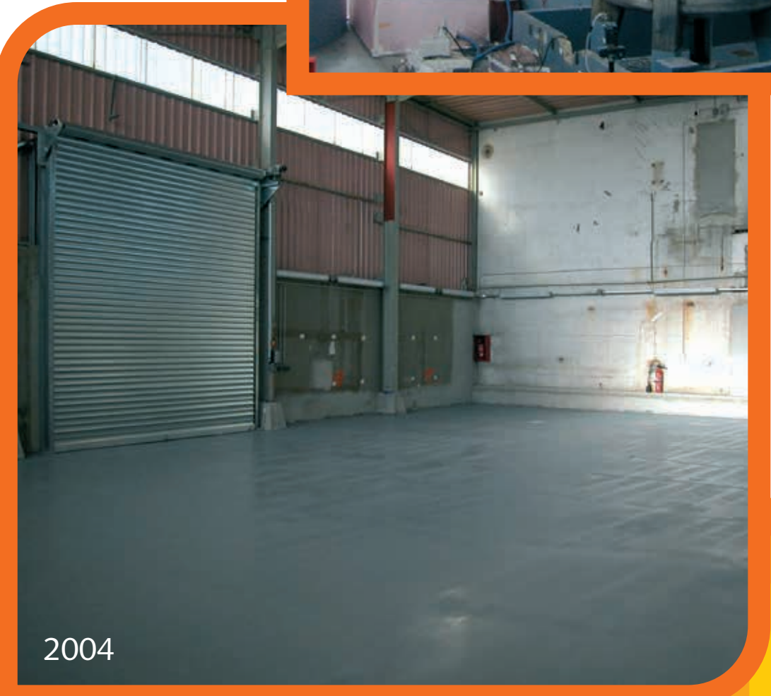
La salle des cuves avant et après démantèlement (2004).
