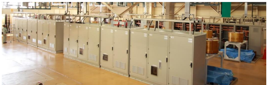
Les quatre alimentations EF2, EF3, EF4, et EF5 en cours d'installation à Naka en juillet 2017.
